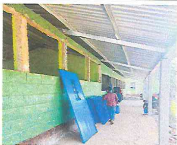
Foto 5: Instalación de puertas de metal y blaques en 3 aulas del modulo 1.
