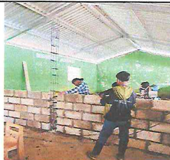
Foto 2: Se sustituye la división de dos aulas de madera por block, construyendo una división de pared en el modulo 1.
