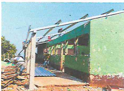
Foto 1: Se realiza el cambio de entechado para 3 aulas y corredor en el modulo 1.
