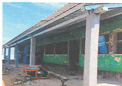
Foto 4: Se sustituye 5 columnas en deterioro del corredor de 3 aulas, en el modulo 1.
