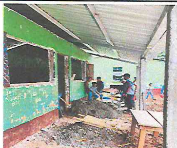
Foto 3: En conjunto con padres de familia realizan el tallado de puertas y ventanas de 3 aulas en el modulo 1.
